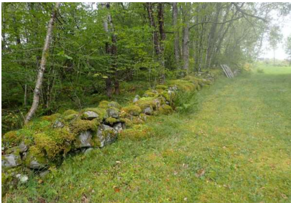
Figur 5. Langs det meste av den sørlege kanten av enga går ein steingard. Skogen her burde vore tynna. Foto; Solfrid Helene Lien Langmo, Bioreg AS © 14.09.2017.
