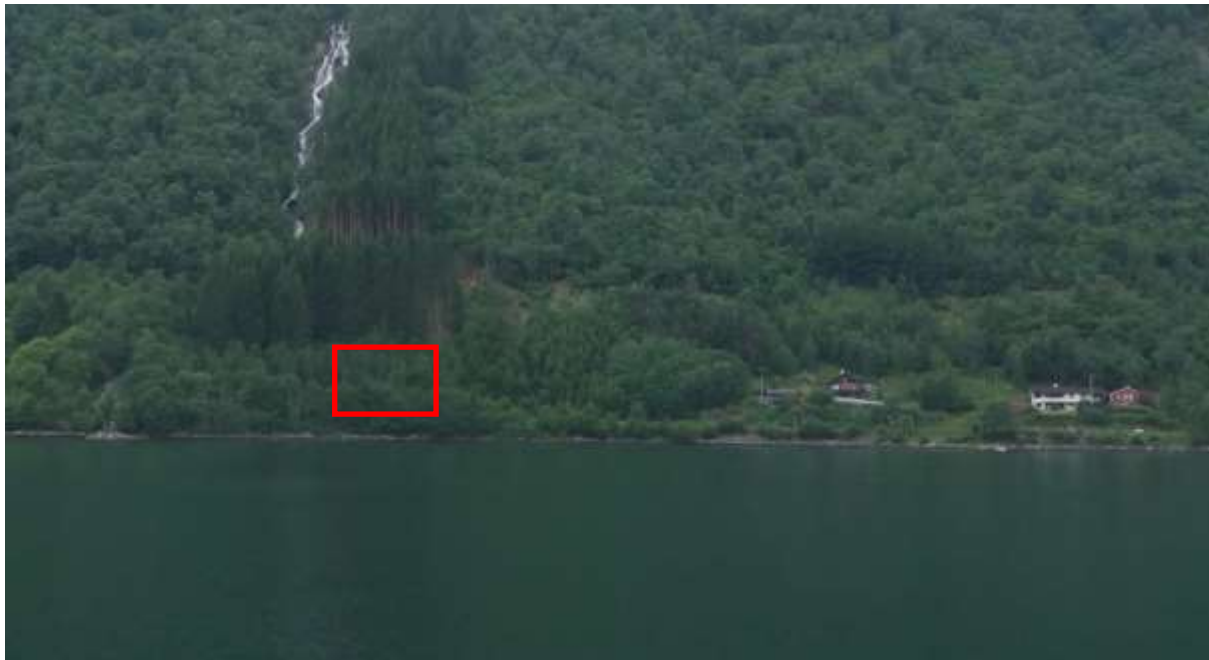
Figur 4. Biletet viser utløpet av Brekkeelvi. Kraftstasjonen er planlagt plassert innanfor den raude firkan- ten, like ovanfor vegen. Som ein ser er det mykje ung lauvskog i området. Artar som hassel, selje og gråor dominerer der det ikkje er planta gran. (Foto: Solfrid Helene Lien Langmo © 06.06.2014).
