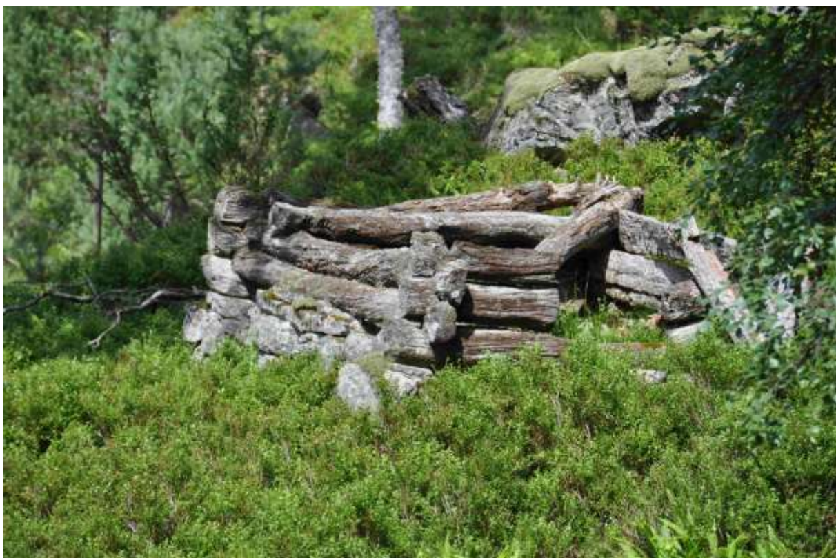
Figur 8. Litt oppom vegen i røyrgatetraseen ligg desse bygningsrestane. I følge Atle Helland så er dette restar etter ei gamal høyløe. Vi går ut frå at det er mogleg å leggja traseen slik at ein unngår å koma i konflikt med dette kulturminnet. (Foto; Karl Johan Grimstad 15.07.2011 ©).
