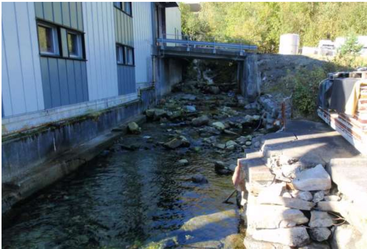
Figur 12. Dette bildet viser nedste del av elva. Flomålet går omlag opp til midt på bildet. Det vart observert noko sjøaure under fossen som kan skimtast under brua. (Foto; Bioreg AS ©).
