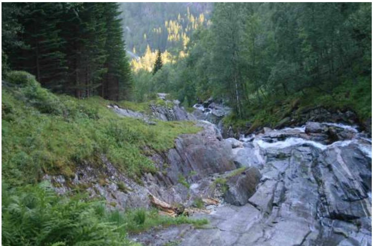
Figur 5. Det er mykje nakent fjell og flå langs Almelidelta og dermed naturleg nok jamt over lite lausmassar. Ein ser at det også er planta gran så å seia heilt inntil elva sume stadar. (Foto; Bioreg AS ©).
